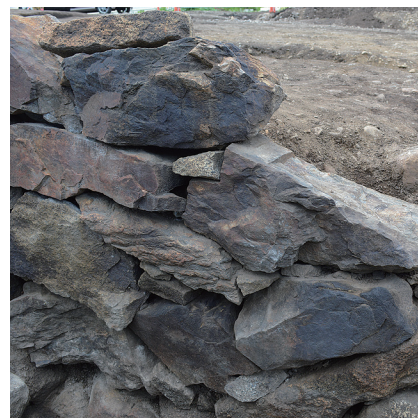
SX600石垣の火災痕跡
