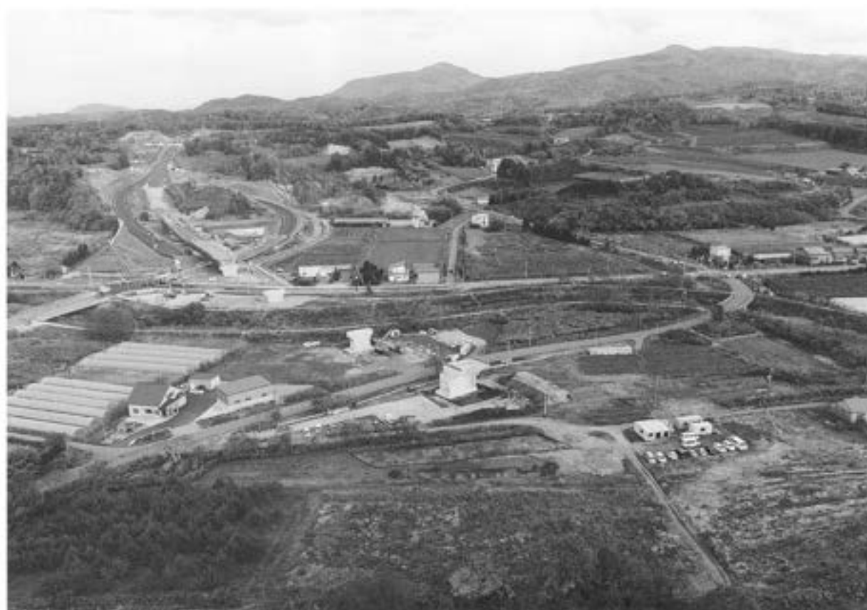
平成30年度調査区遠景(北西から)
