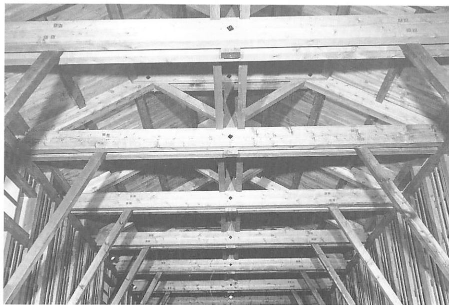
石蔵 小屋組（文書倉に倣う） 北より見る
