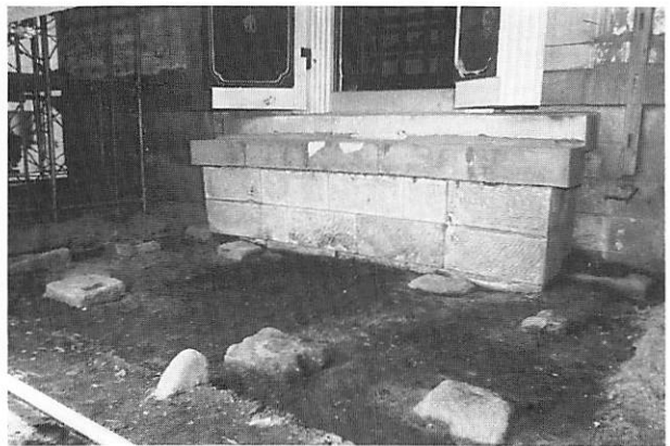
6 解体中 前室解体後、礎石状況
