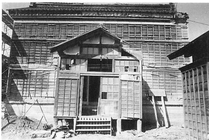
1 修理前 正面（東面）
