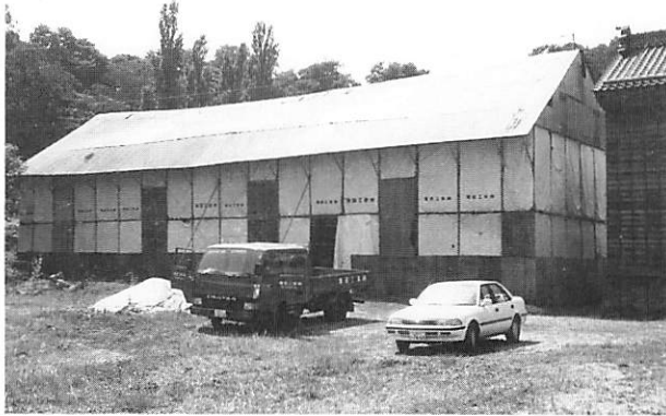
2 素屋根 東北から見る
