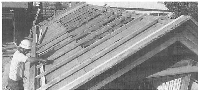
4 組立中 軒廻り部材取付修整
