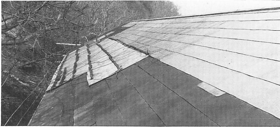
1 修理前 背面屋根状況 鉄板が葺直し・修理されていた
