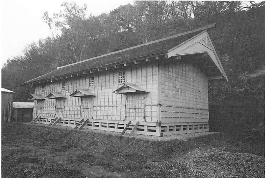
米味噌倉 正側面 北西より見る
