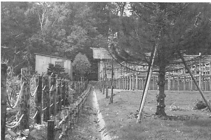
図81 内周保護柵施工状況
