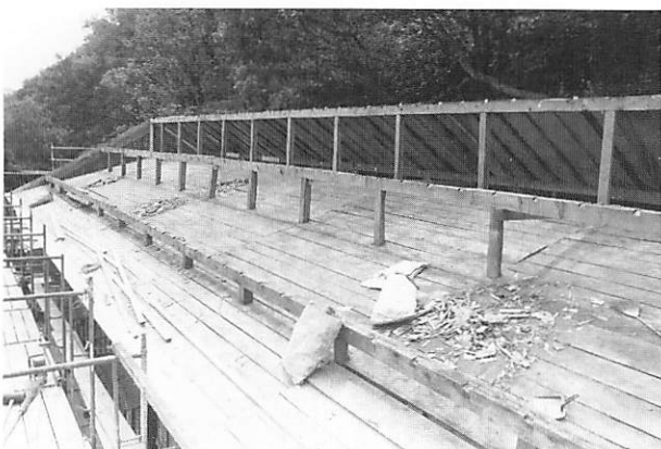
4 木工事 小屋組修理、不陸調整
