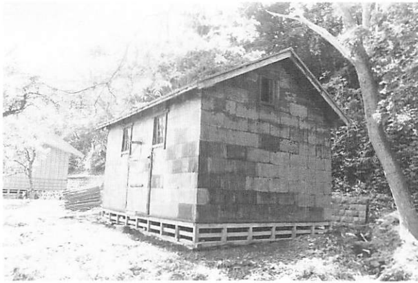
2 修理前 正側面 西北より見る
