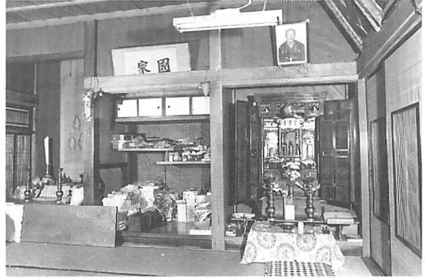
1 修理前 「床の間」 西面
