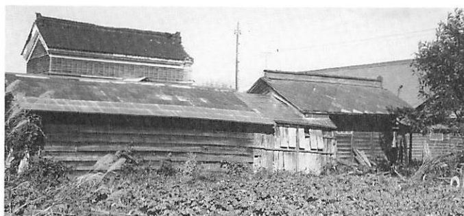
3 修理前 便所・物置背面 東より見る
