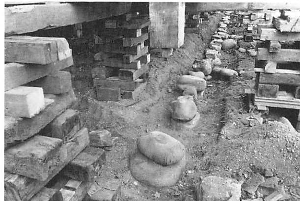
1 揚屋工事 (基礎工事・木工事) 土台・柱根修理、礎石コンクリート基礎のうえ据直し (土台を抜いた状態)
