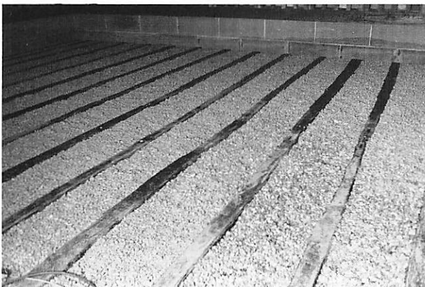
5 木工事 本体内部 根太組砂利詰終了
