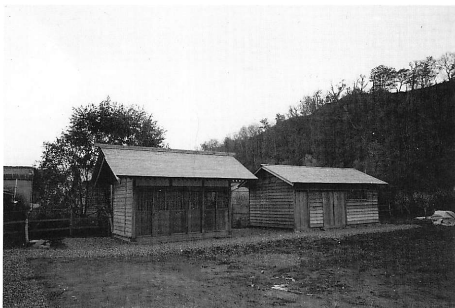
便所・物置 西より見る
