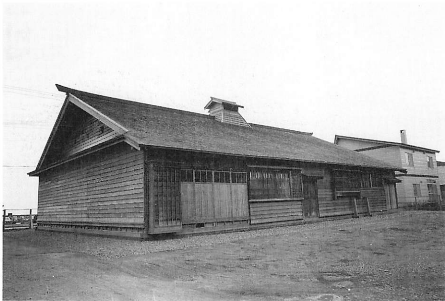
主屋 背側面 南西面より見る
