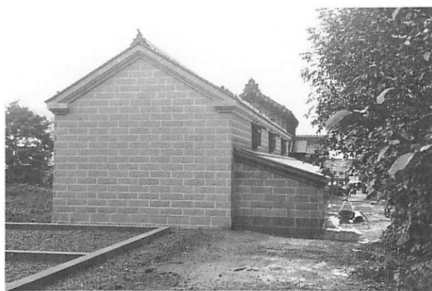
2 下屋廻り工事終了
