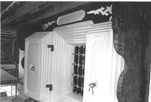
5 左官工事 北妻窓扉漆喰塗直し
