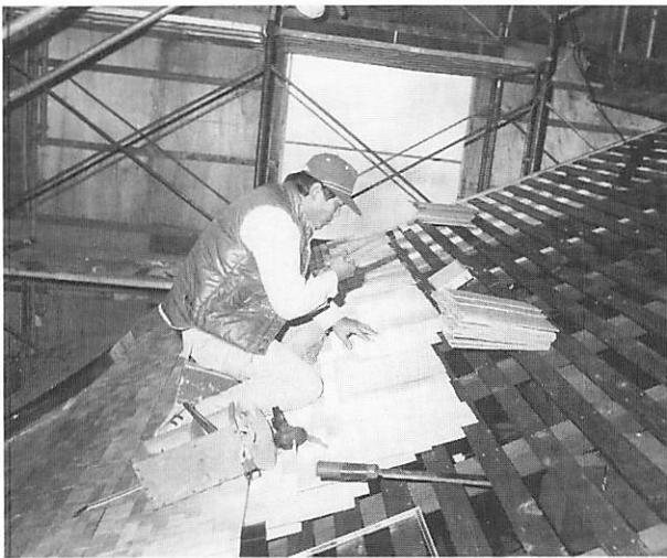
2 屋根工事 桎葺
