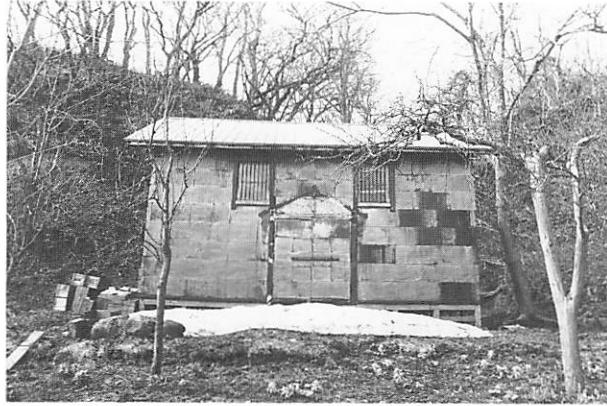
1 修理前 正面（北面）
