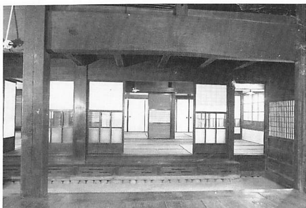
2 竣工 「漁夫溜場」 東より見る
