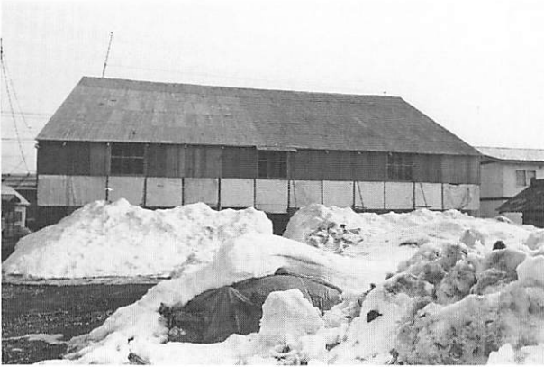
1 素屋根 背面全景
