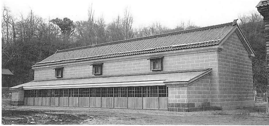
石蔵（復原新築） 正側面 北東より見る
