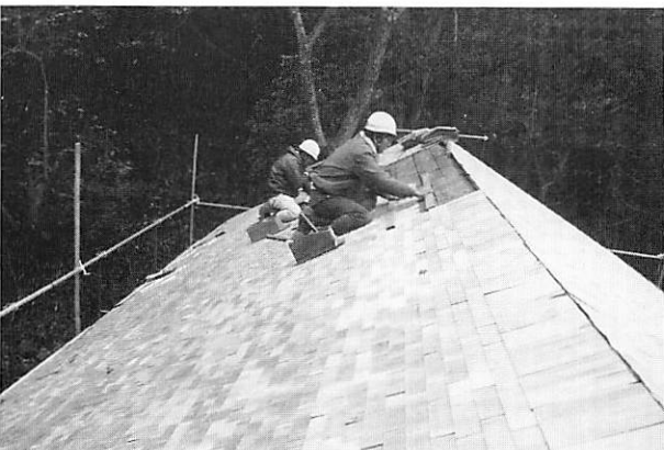
5 屋根工事 土居葺 (サワラ材)
