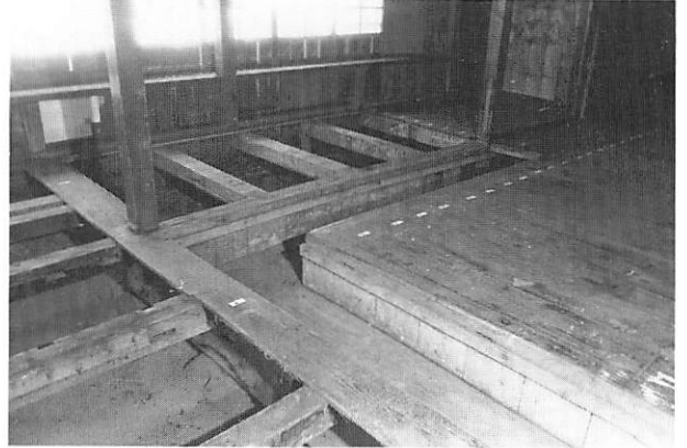
1 解体中 「漁夫溜場」床組 北西より見る 転用材が用いられている
