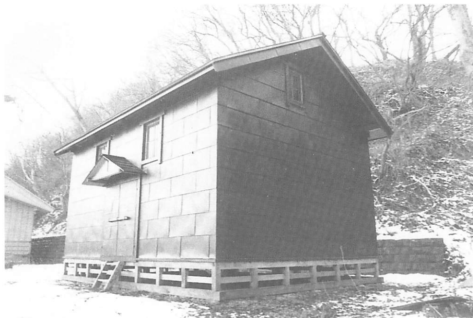
1 竣工 正側面全景 西北より見る
