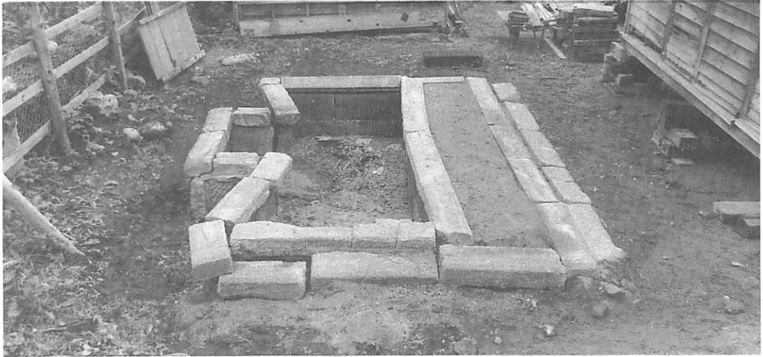
1 解体中 木部曳家後、基礎及び便槽状況 北より見る
