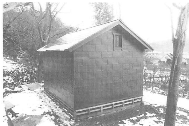
3 竣工 背側面 東南より見る
