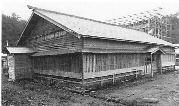
3 修理前 正側面 北東より見る
