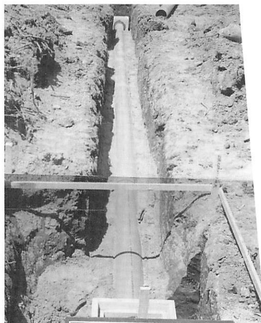
図43 V U管パイプ布設状況
