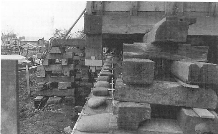
基礎工事(持揚)
