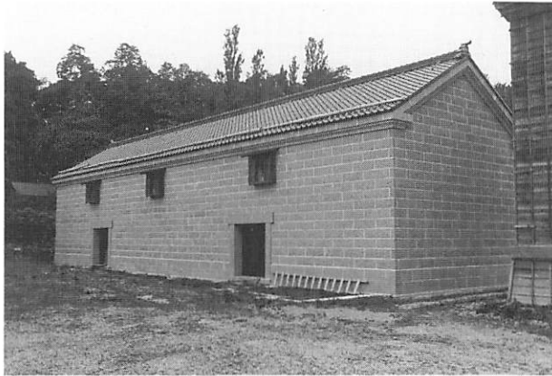
3 本体工事（外廻り）終了 下屋工事準備
