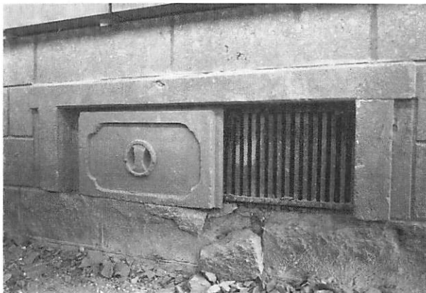
図18 修理後の状況
