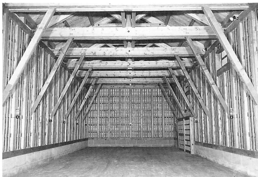
石蔵 内部（方杖は補強） 南より見る
