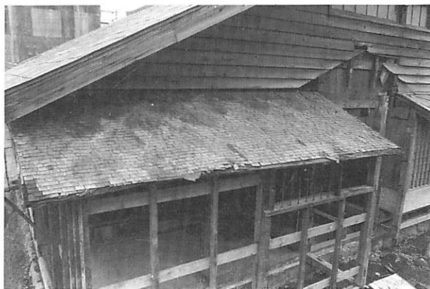
1 解体中 東面下屋（後設）の解体
