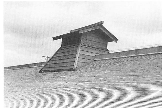
6 竣工屋根及び煙出し
