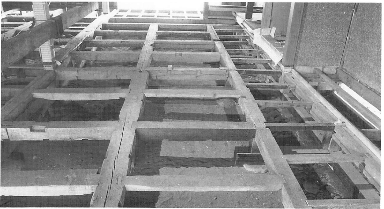
3 解体中 座敷床組 北より見る
