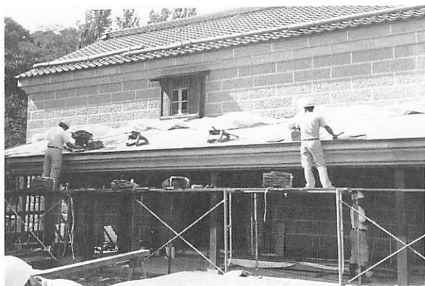
1 屋根工事 下屋桁葺作業中
