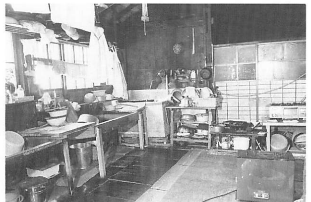
5 修理前 「台所」 東より見る
