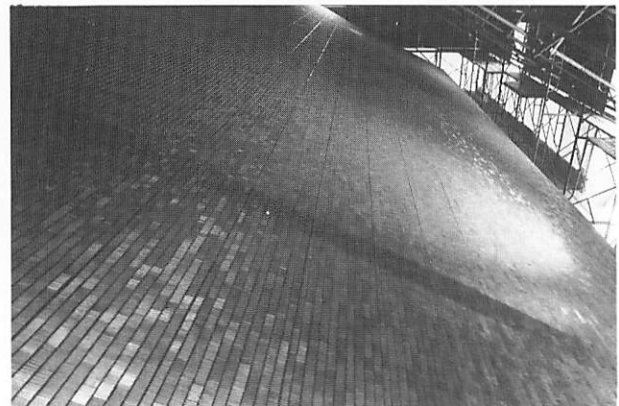
4 屋根工事 桎葺葺上り 南面西より見る
