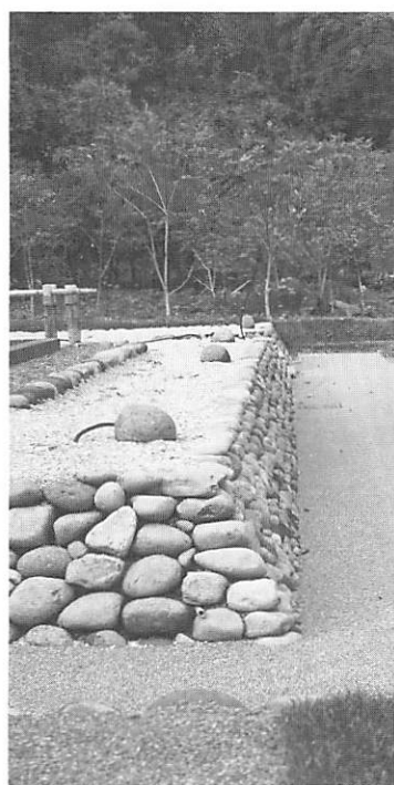
図41 石積擁壁施工状況
