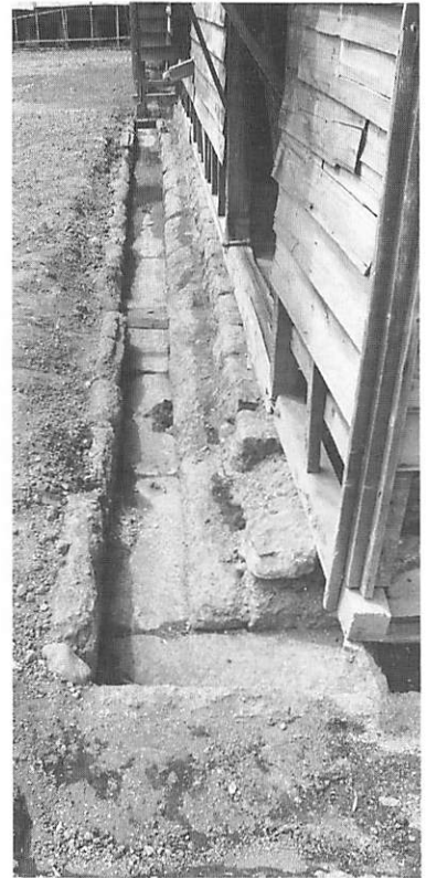
3 修理前 埋まっていた排水溝
