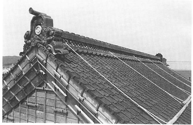
2 屋根工事 瓦葺終了
