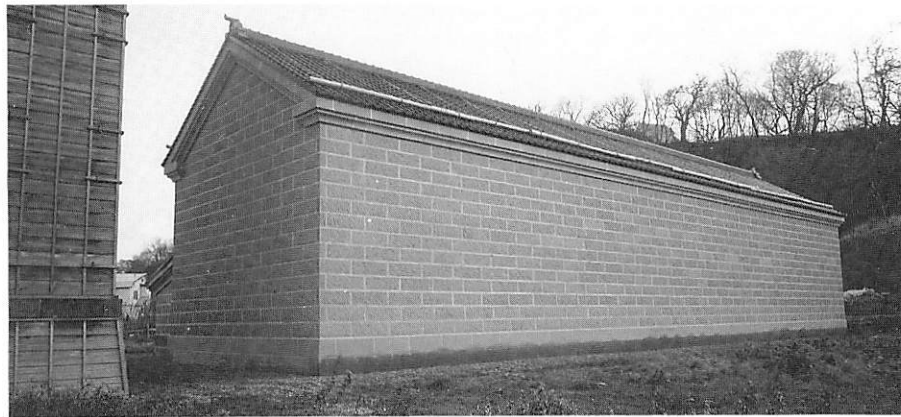
石蔵 背面 西より見る
