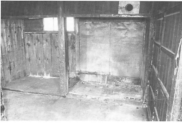
1 後設東面下屋の内部
