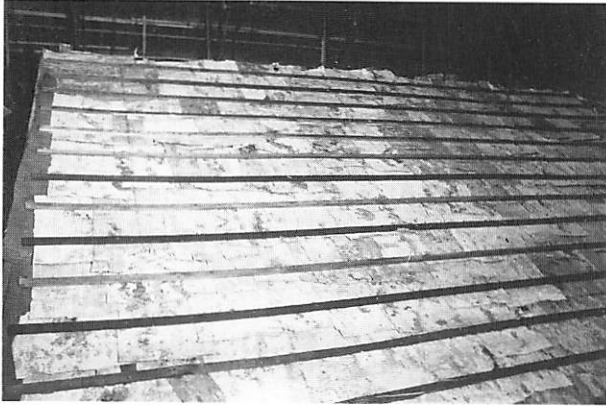
1 屋根工事 土居葺(樺皮)葺替
