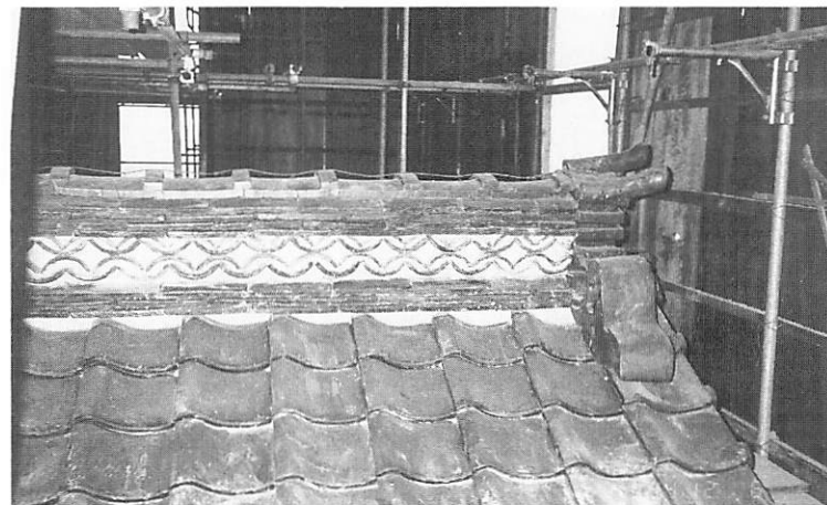
同上 修理後の状況
