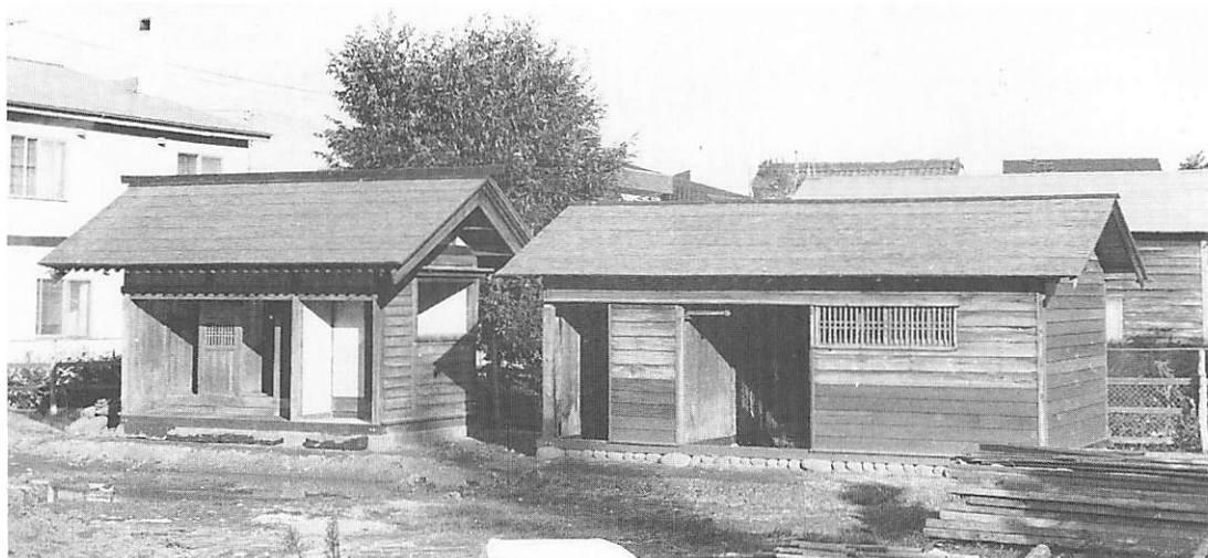
1 竣工 便所・物置 西より見る
