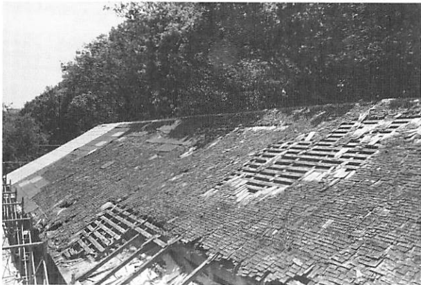
2 解体中 鉄板を剥した状況 葦葺が残存した
