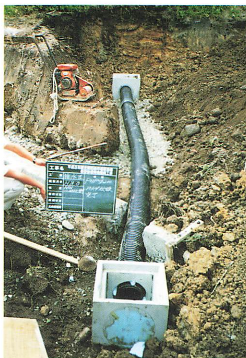
写真19 排水パイプ伏設状況
