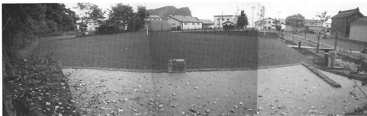
写真9 干場ダスト舗装状況
