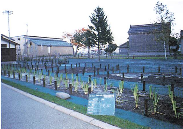
写真29 植栽工(着工前)
