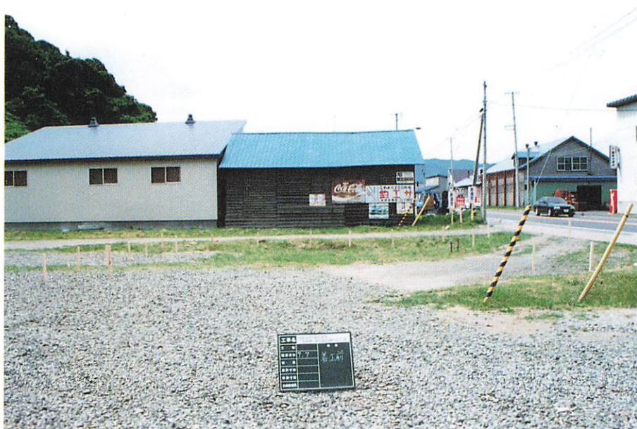
写真33 便益施設(着工前)
