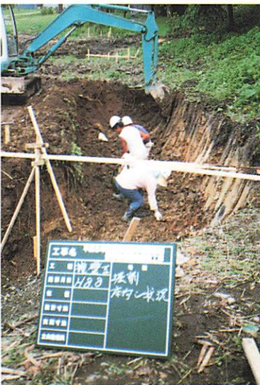
写真25 擁壁工(掘削・床均し)
