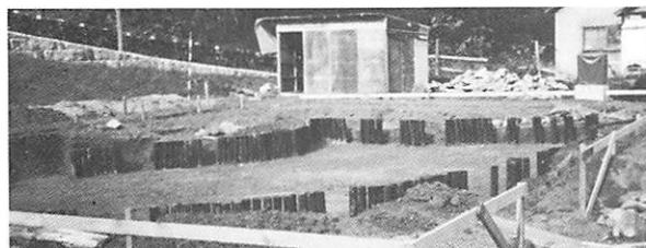
fig.-15 園池護岸杭施工状況
