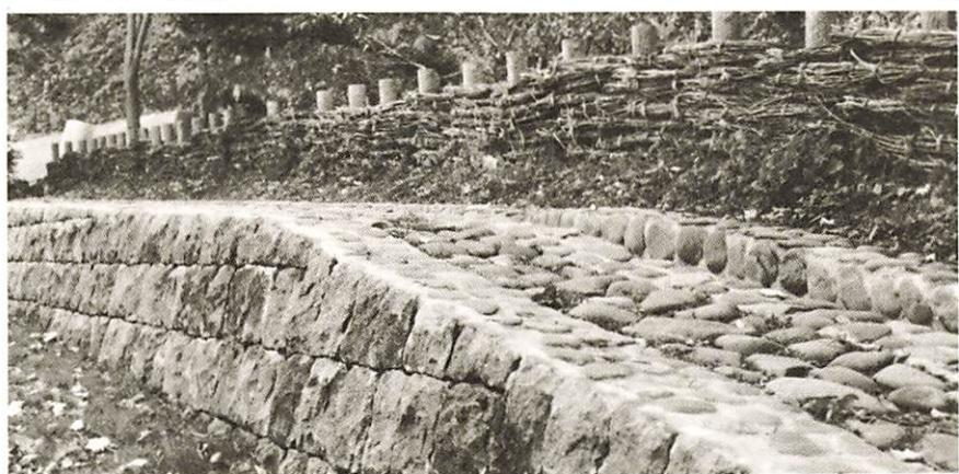
写真-31 外周玉石練積排水溝，擁壁
