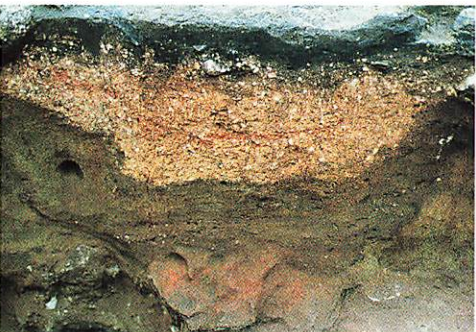
GP-852 セクション観察状況（北東→南西）
