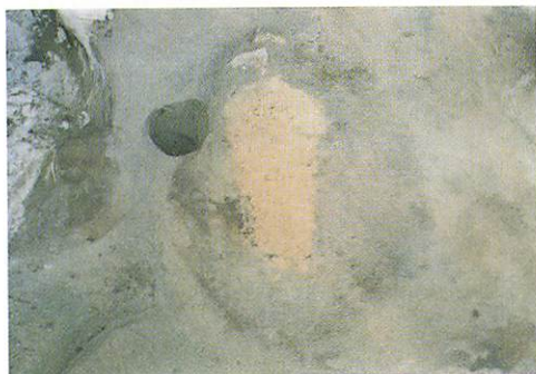
2) GP-583 プラン確認状況 (中央部は, 砂質凝灰岩)
