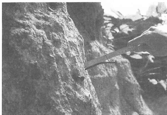
写真1 フゴッペ洞窟外壁に打ち込んだ釘 (侵食剥離測定用) 1971年9月6日撮影
