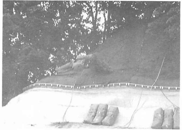
写真2 植生シート施工（平成15年9月）
