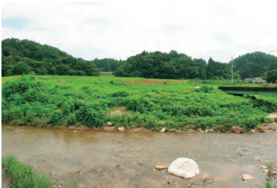
20 MH-SG. B2現況 (北西から)
