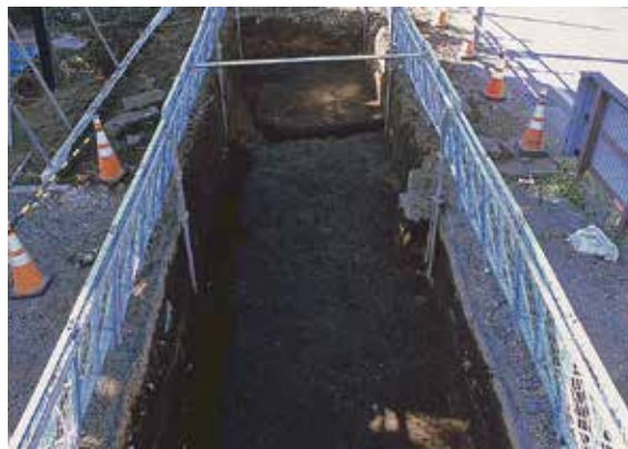
2a区 全景 (南東から)
