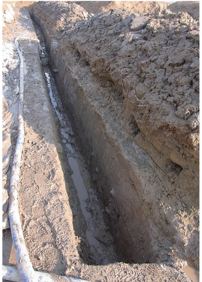
SX01 北側擁壁部分掘削状況
