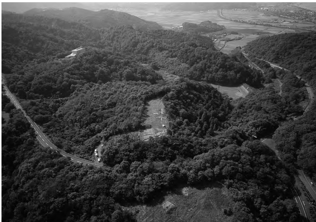
2 松尾頭墳丘墓群遠景 北東から
