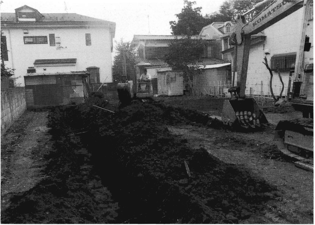
確認調査風景
