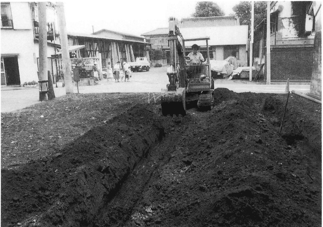
確認調査風景
