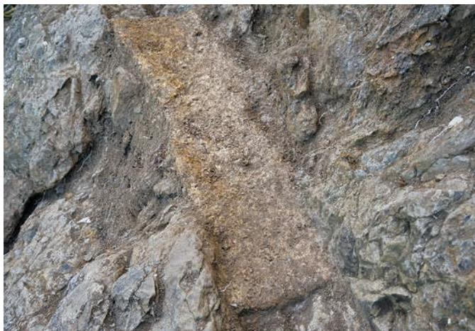
SD3 崩落部 黄褐色シルト貼付補修部 検出状況 (北東から)
