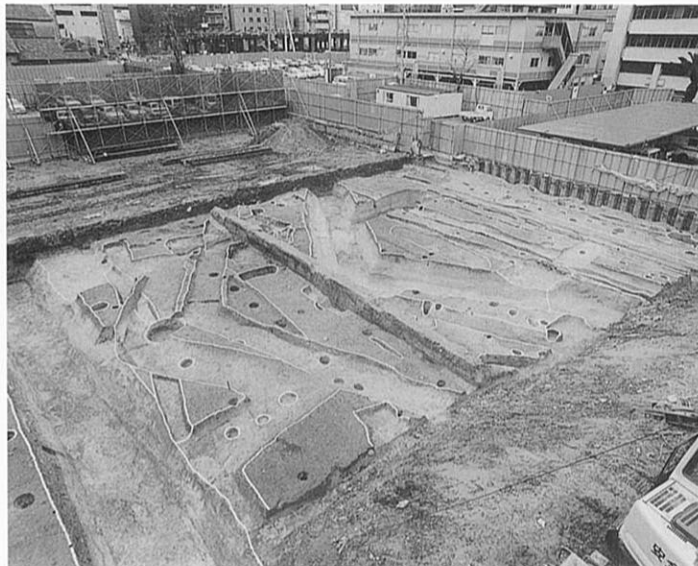
4A-8 トレンチ (北から)
