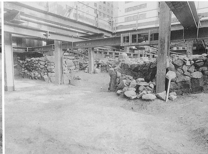
3B-6・8 トレンチ石組 (北西から)
