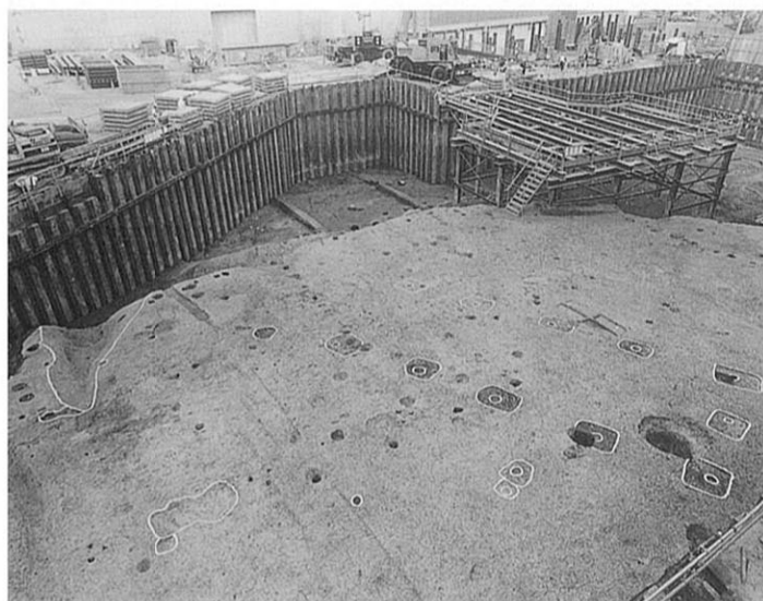
5B-19 トレンチ (北から)
