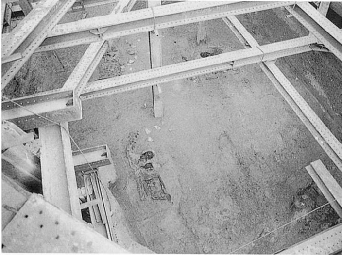
3A-7 トレンチ西部 8a 層新段階 (西から)
