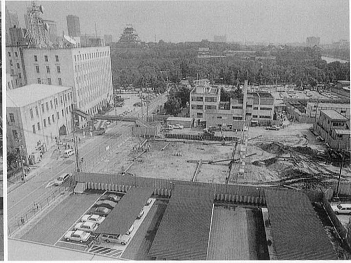
4A 調査区 (西から)
