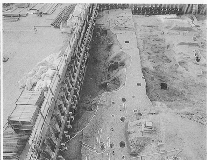
6A-5 トレンチ11層上面 (東から)
