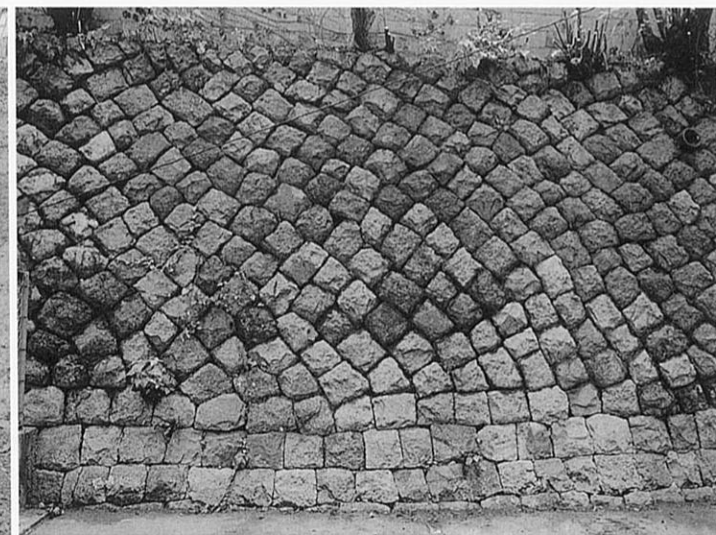
1A 調査区谷町筋側石積 (西から)
