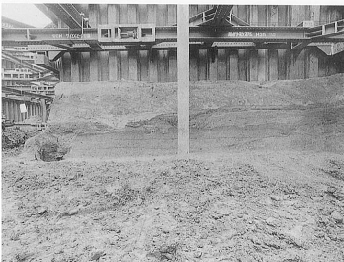
3A-7 トレンチ7~10層断面 (東から)
