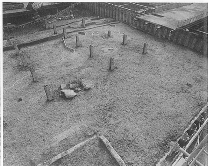
2D-4 トレンチ (西から)
