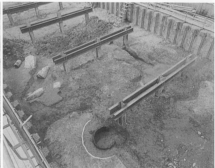
2B-4 トレンチ (南西から)
