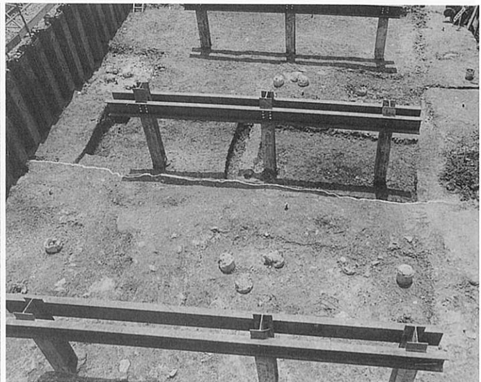
2B-2 トレンチ (北から)
