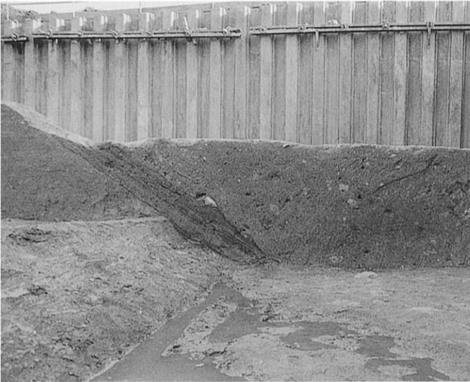
1B-6 トレンチ堀1 断面 (北から)
