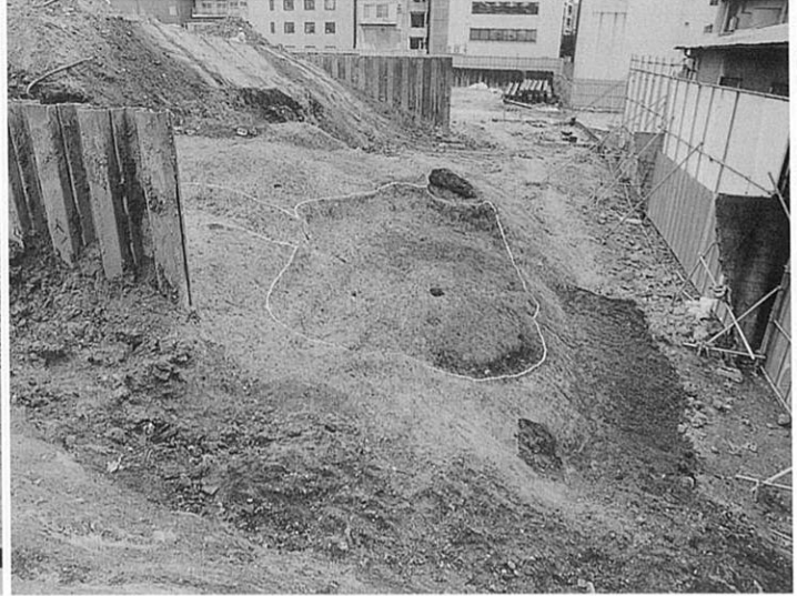
3A-8 トレンチ西部 (北から)
