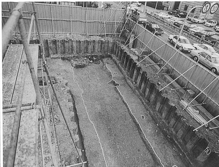
1B-1 トレンチ北部 (東から)
