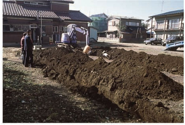
2. 確認調査風景
