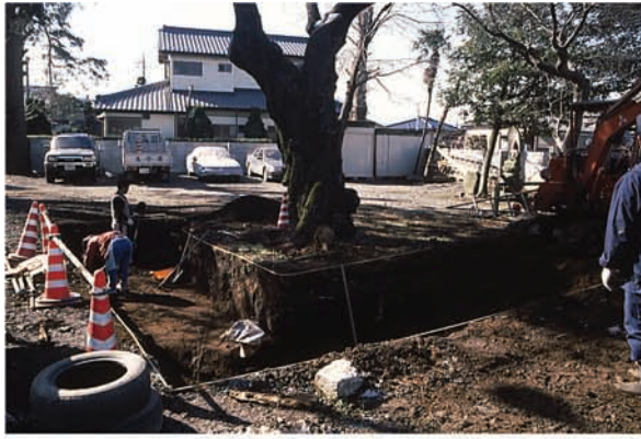
1. 表土剥ぎ風景
