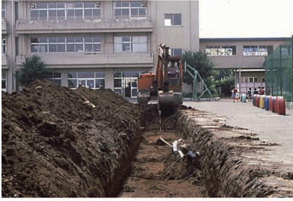
1. 確認調査風景
