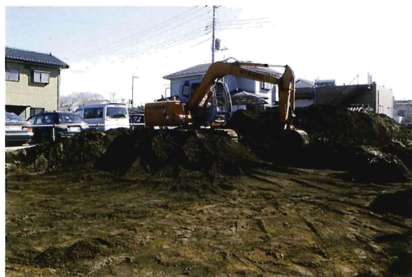
1. 表土剥ぎ風景
