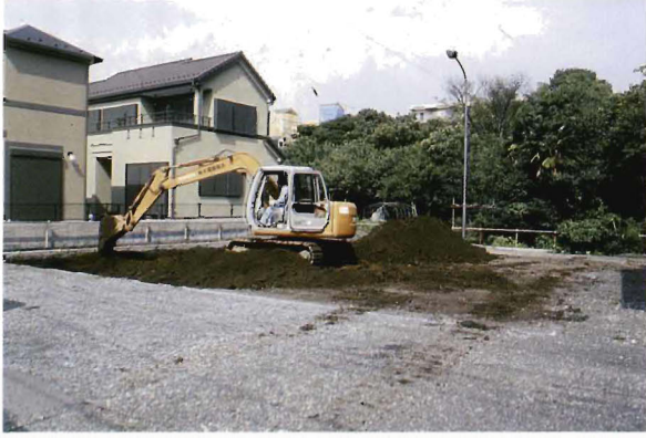
1. 表土剥ぎ風景
