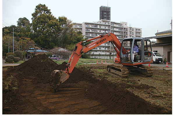
2. 表土剥ぎ風景
