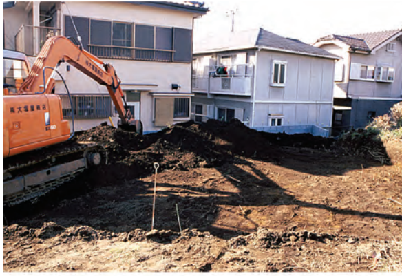
1. 表土剥ぎ風景
