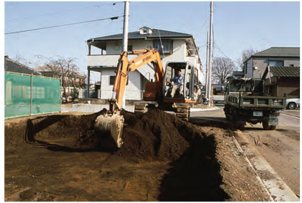
2. 表土剥ぎ風景
