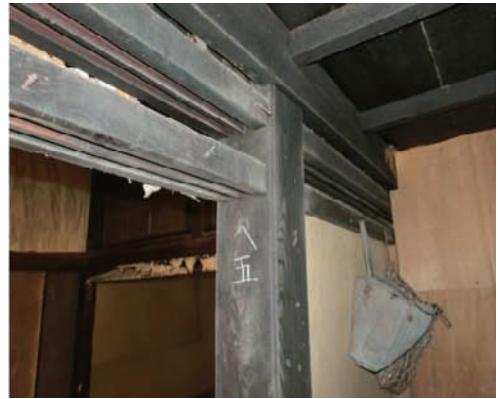
(へ五) の柱 上段の間は、当初の鴨居の下に後補の鴨居が取り付けられている
