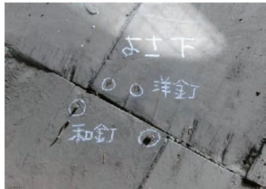
茶の間上部2階吹抜部分の床板 後補の板は洋釘を使用、当初の床板には和釘が使われている
