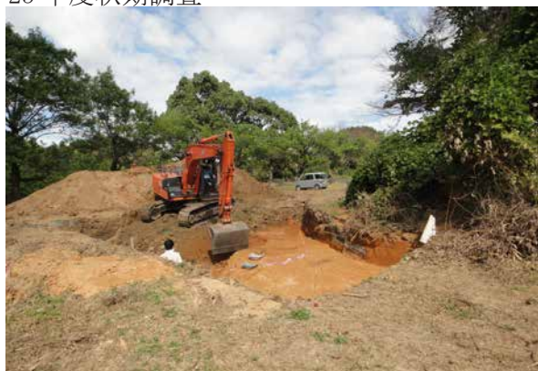
①表土剥ぎ風景 1 (南西から)
