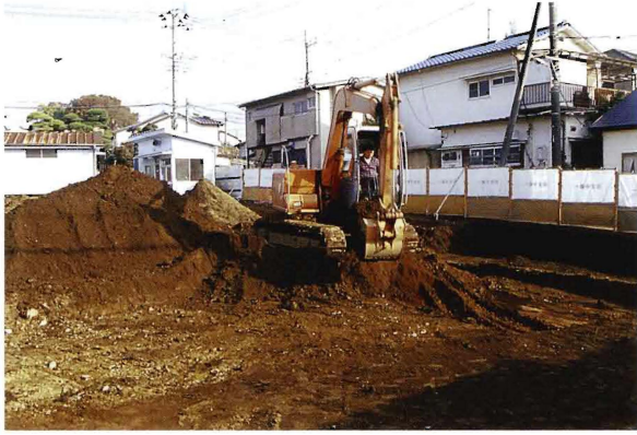
1. 表土剥ぎ風景
