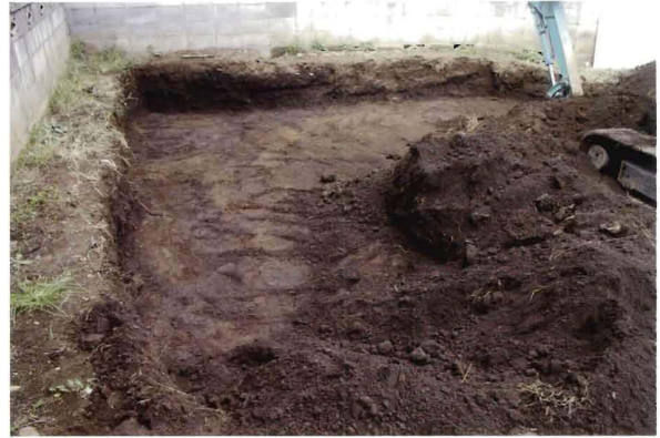
2. 表土剥ぎ作業風景
