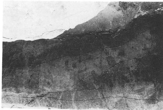
fig.25 SD-01 断ち割り状況
