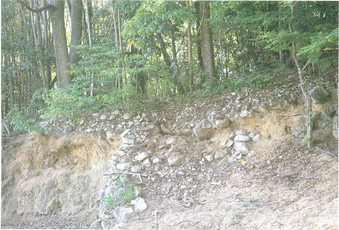
上段斜面・中段テラス断面（南から）
