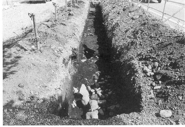
4. E トレンチ全景
