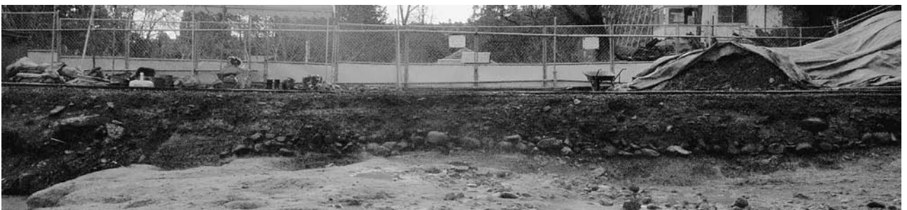
5. II区南壁面4 (北から)
