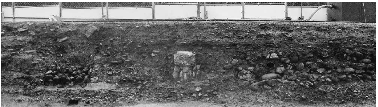
3. II区南壁面2 (北から)
