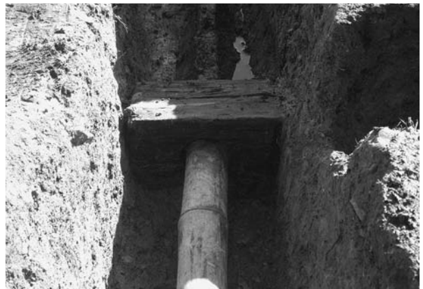
3. 1号竹樋 継手検出 (南から)
