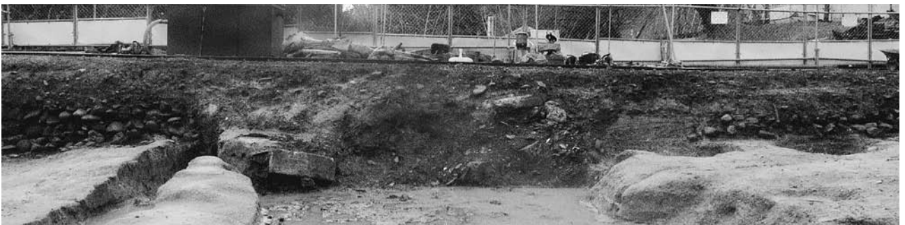
4. II区南壁面3 (北から)
