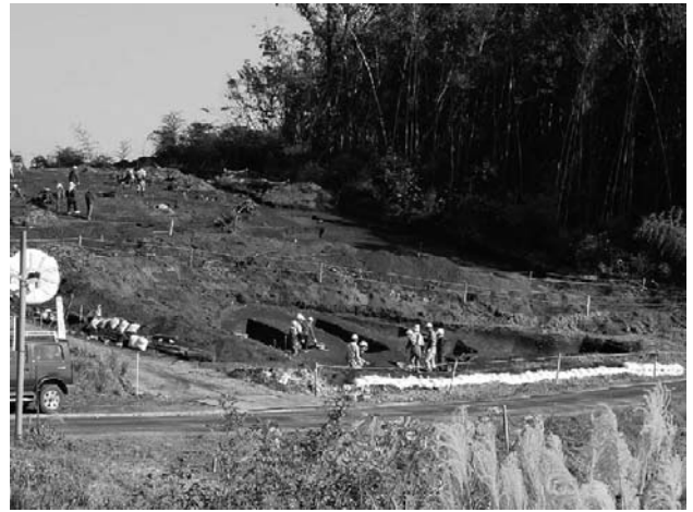
調査区近景 (南西から)
