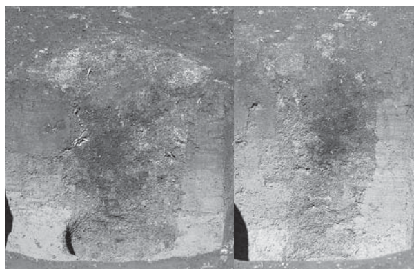
SA 14-P 1、2 断ち割り状況
