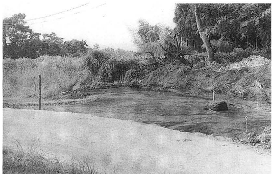
(4) 表土剥ぎ凌風景（南西から）
