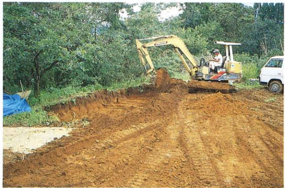
図版3 重機による掘削
