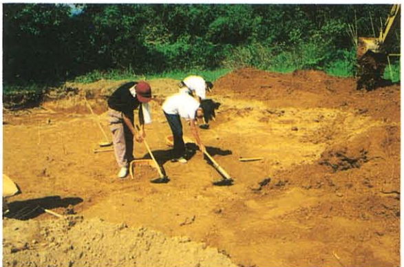
図版5 掘削作業
