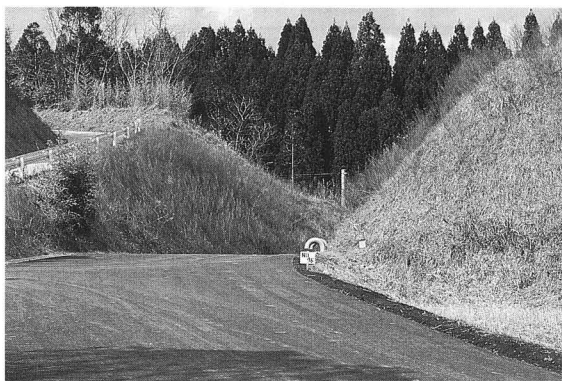
図版23 調査後の様子
