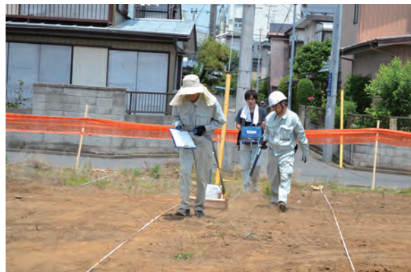
3. GPR探査 調査風景
