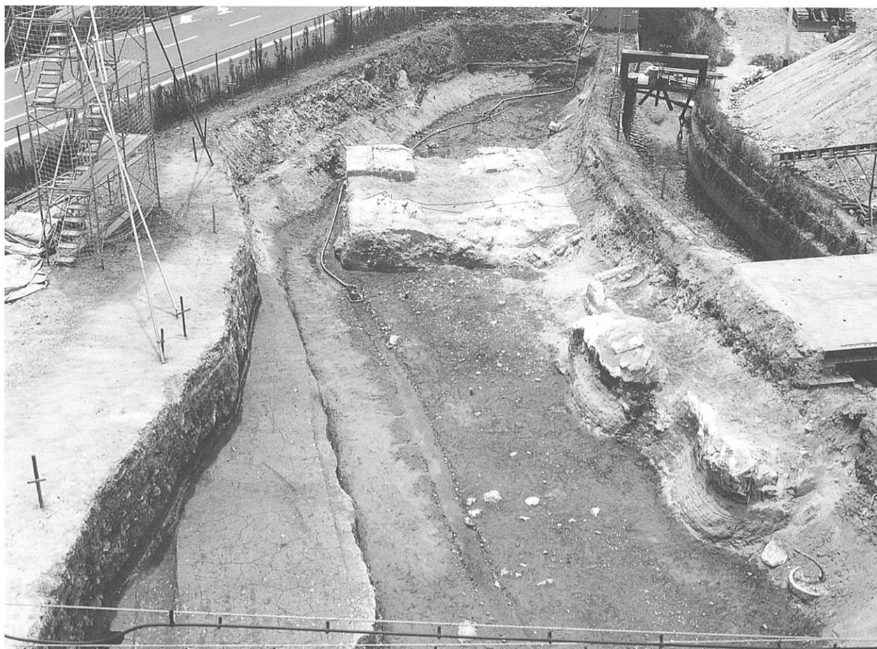
(1) C調査区完掘状況(北から)
