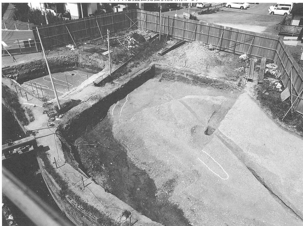
(2) A・B調査区完掘状況(北東から)
