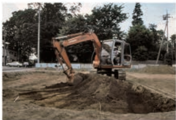
1. 表土剥ぎ風景
