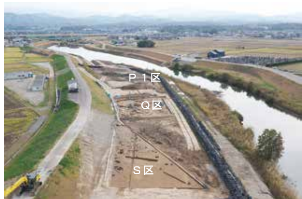
調査地遠景 下流側（西南）から望む
