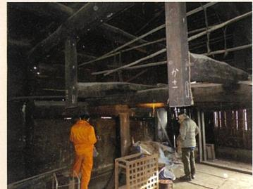
写真12 2階吹抜 柱切断跡
