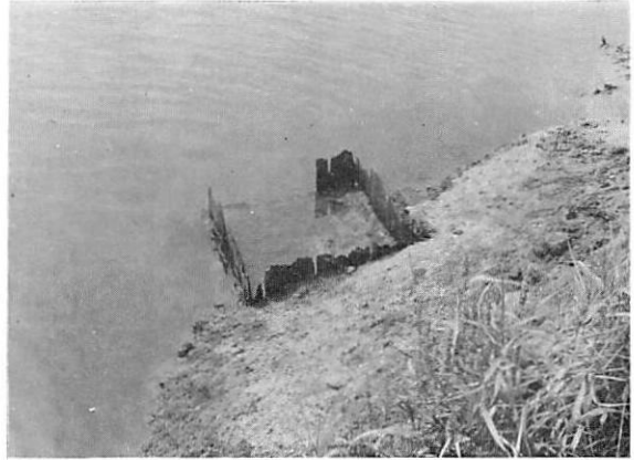
No. 2 外板の一部を抜き去られたC11区第1号井戸
