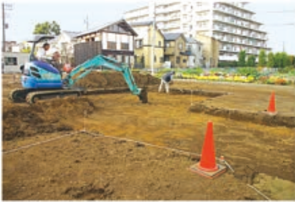
3. 表土剥ぎ風景 (第62-1地点)
