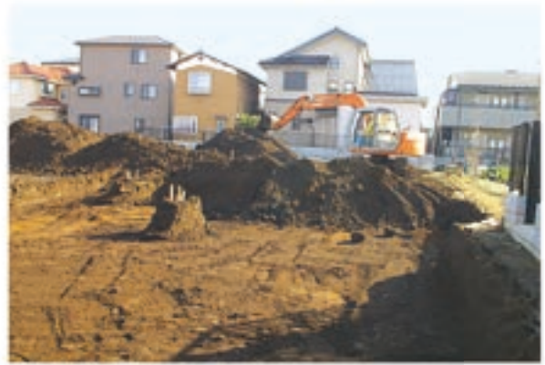
4. 表土剥ぎ風景 (第62-2地点)
