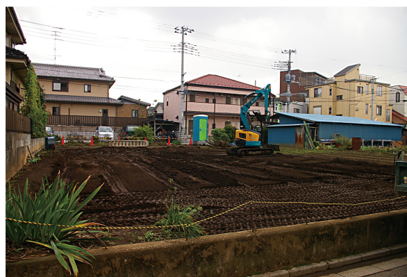
8. 埋め戻し作業風景
