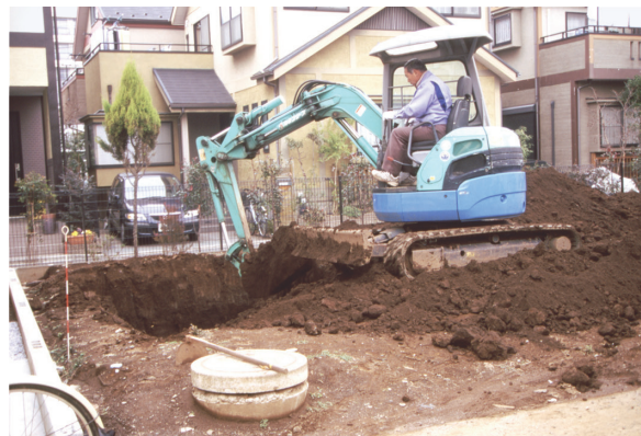
2. 表土剥ぎ風景
