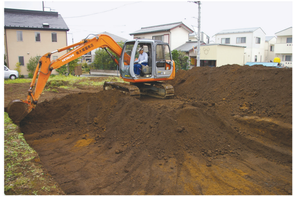
2. 表土剥ぎ風景
