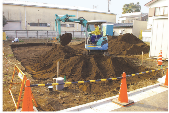
2. 表土剥ぎ風景
