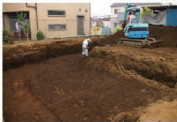
2. 表土剥ぎ風景
