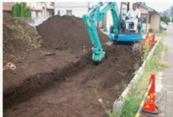
2. 表土剥ぎ風景
