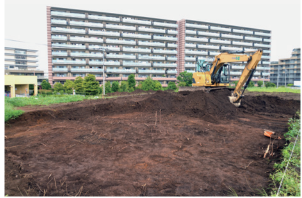
2. 2区表土剥ぎ(西から)
