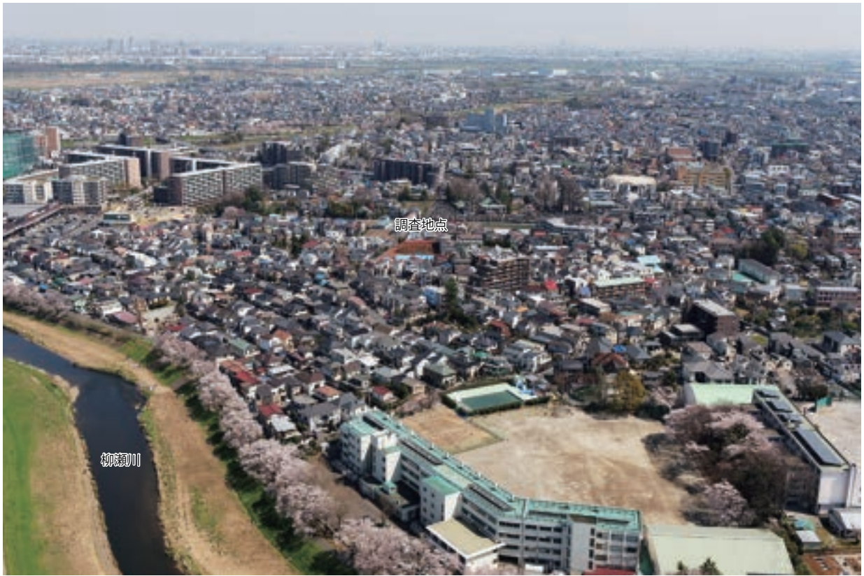
1. 調査地点遠景（西から）
