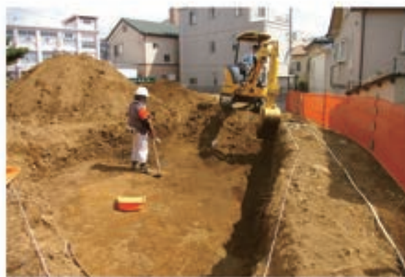
2. 表土剥ぎ風景
