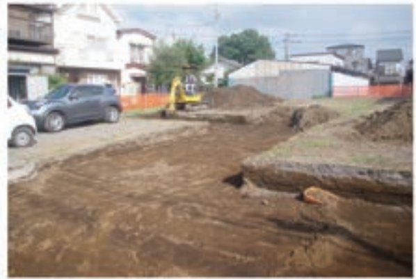
2. 表土剥ぎ風景
