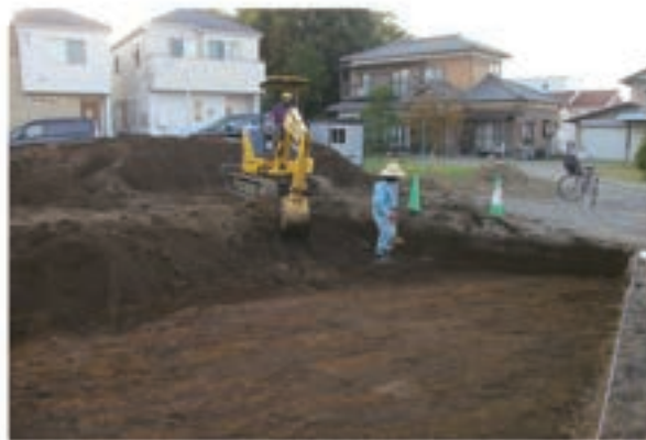
2. 表土剥ぎ風景
