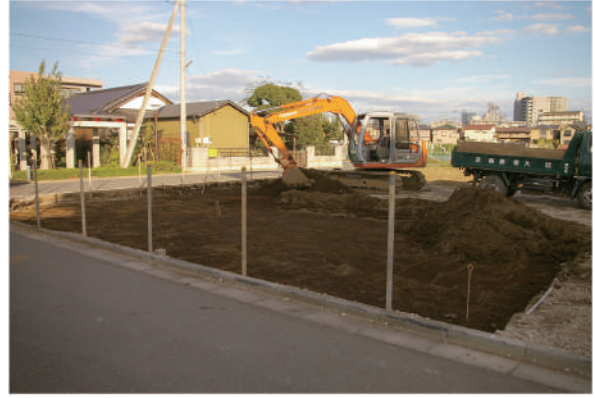
2. 表土剥ぎ風景(西から)
