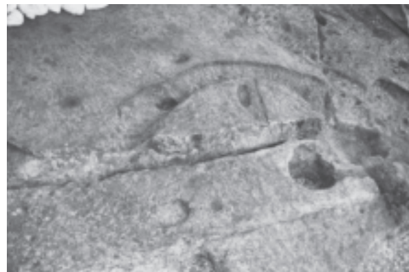
⑤10号溝 完掘状況 (南西から)
