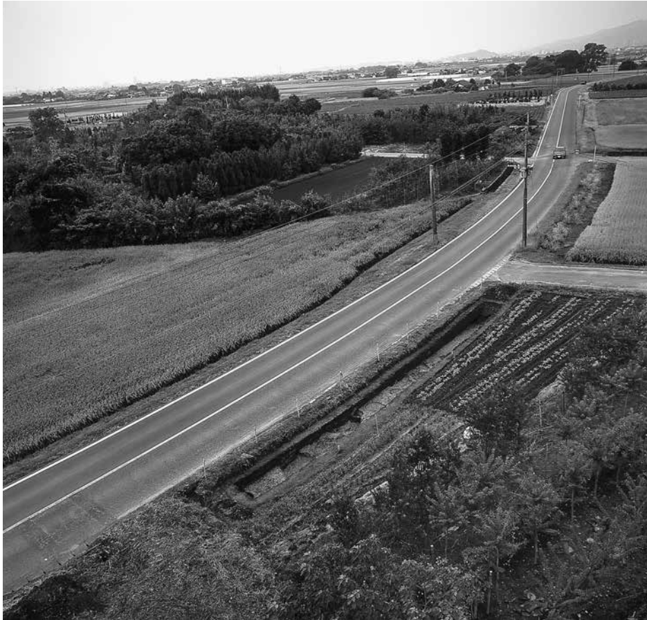
D区 全景 (東上空から)
