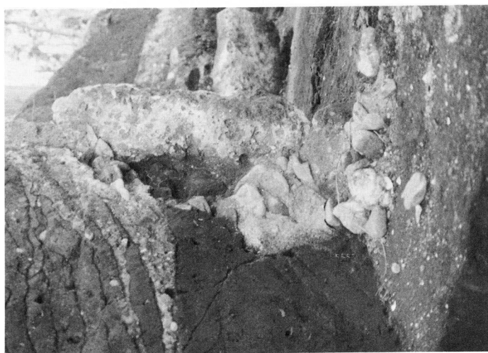
奥壁裏込め状況
